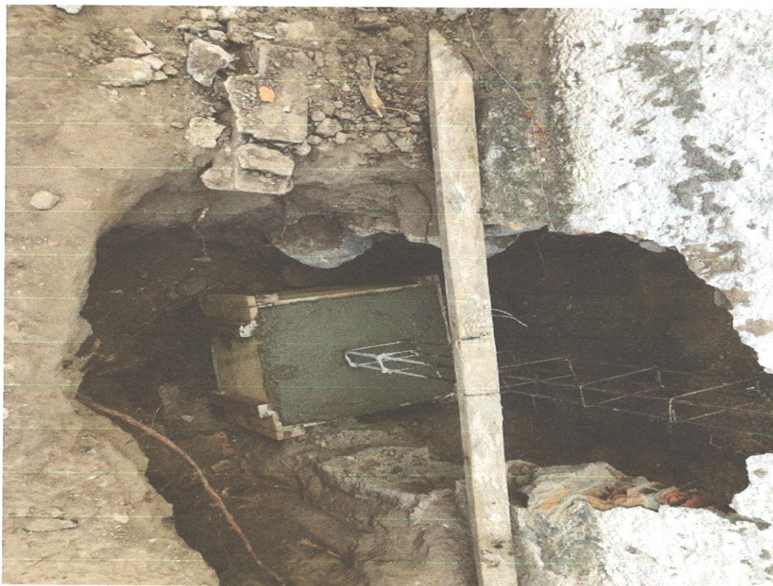
FOTO 22 EXECUÇÃO DE FUNDAÇÃO COM FORMA
