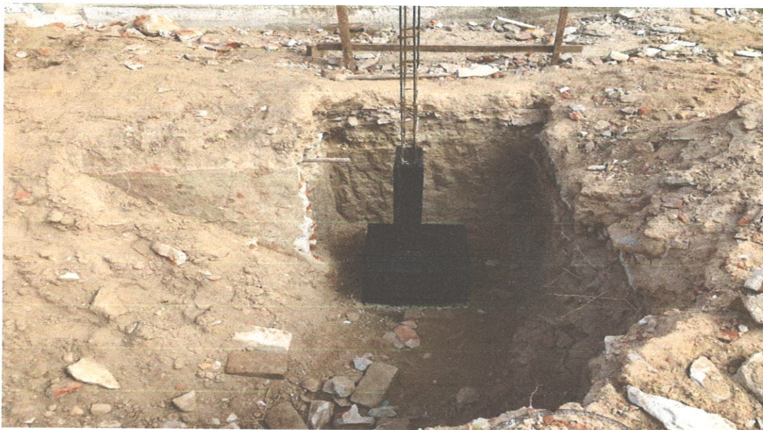
FOTO 19 IMPERMEABILIZAÇÃO DA FUNDAÇÃO
