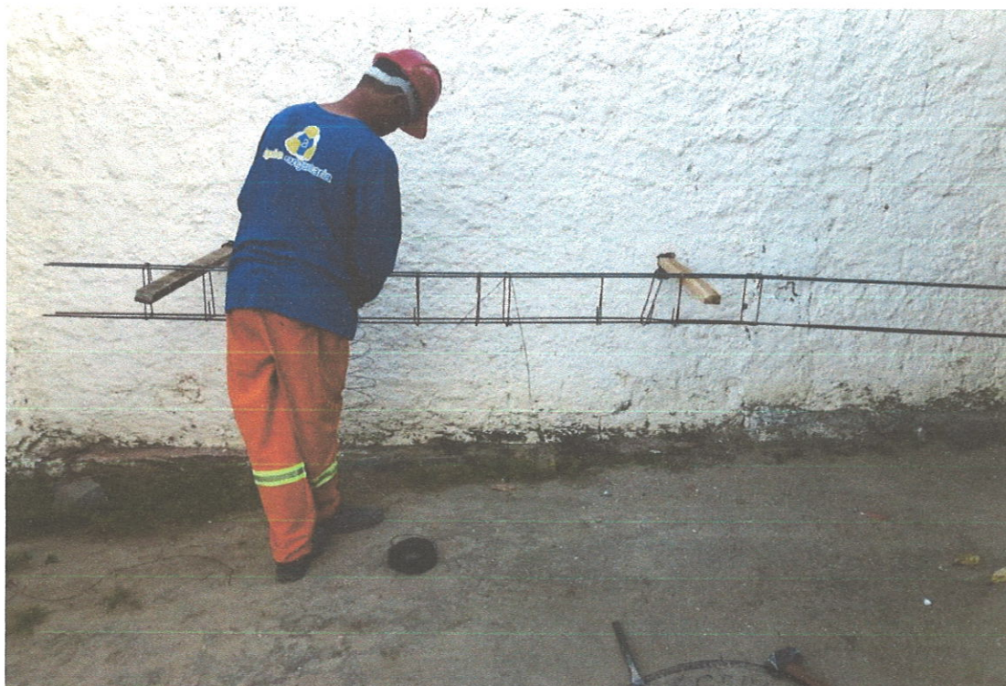
FOTO 16 EXECUÇÃO DE FERRAGEM PARA OS PILARES
