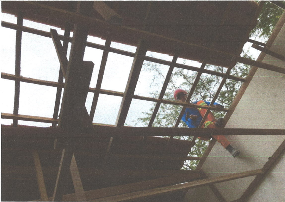
FOTO 10 REVISSÃO DE TELHAMENTO
