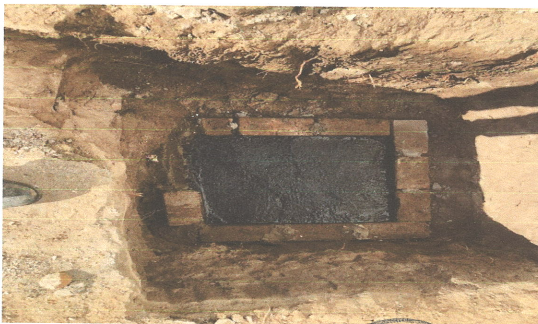
FOTO 23 CONCRETO MAGRO IMPERMEABILIZADO
