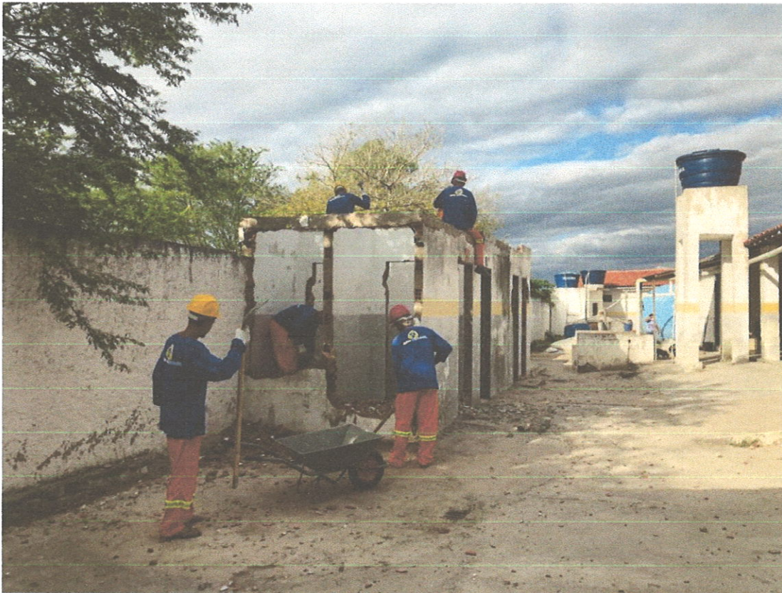
FOTO 05 DEMOLIÇÃO DE ALVENARIA
