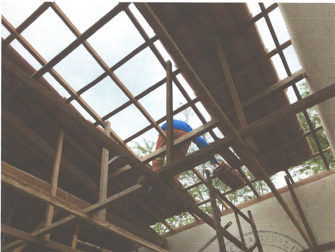
FOTO 11 REVISSÃO DE TELHAMENTO
