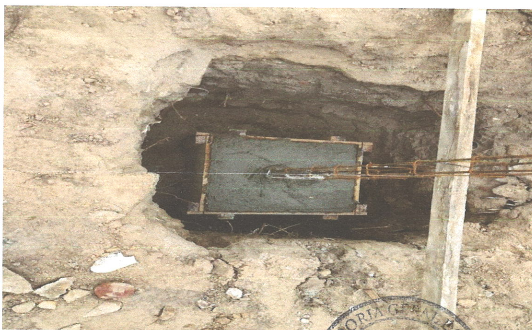
FOTO 27 EXECUÇÃO DE FUNDAÇÃO
