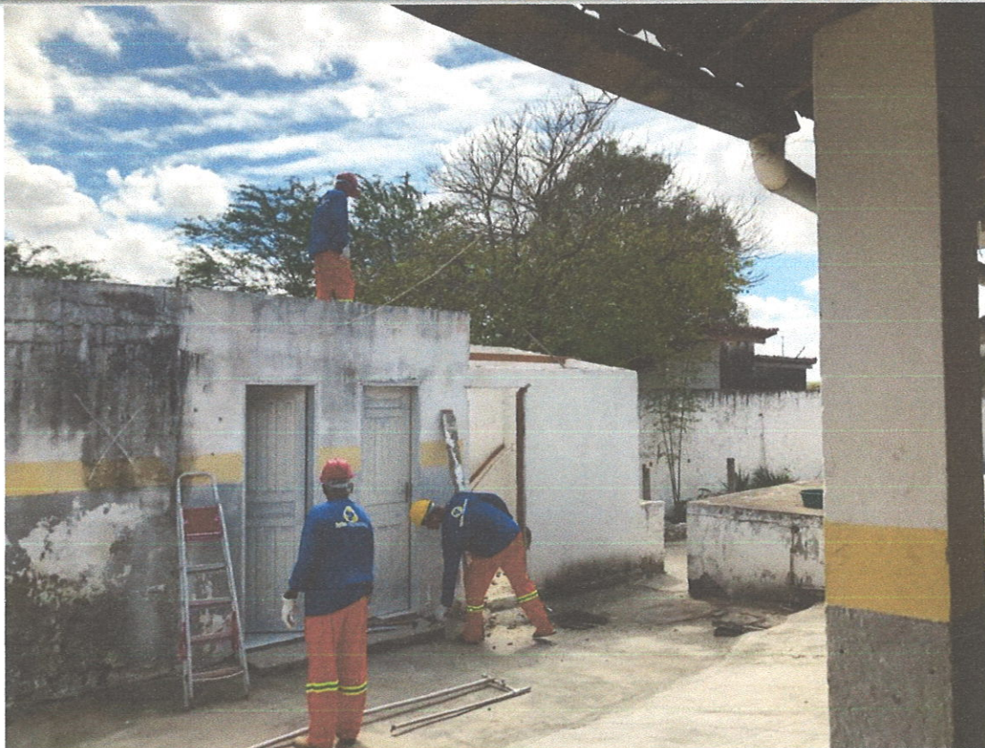
FOTO 01 DEMOLIÇÃO DE TELHAMENTO
