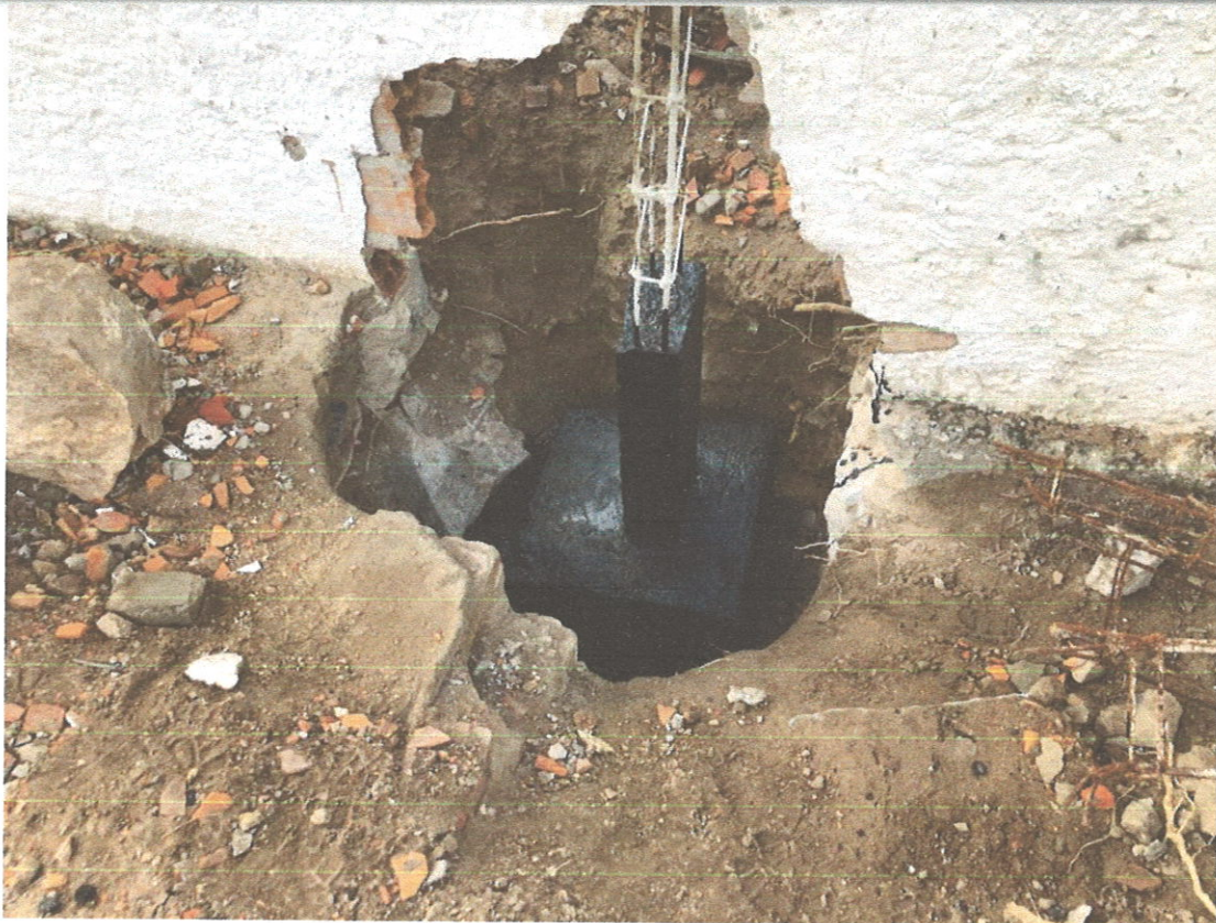
FOTO 19 IMPERMEABILIZAÇÃO DA FUNDAÇÃO
