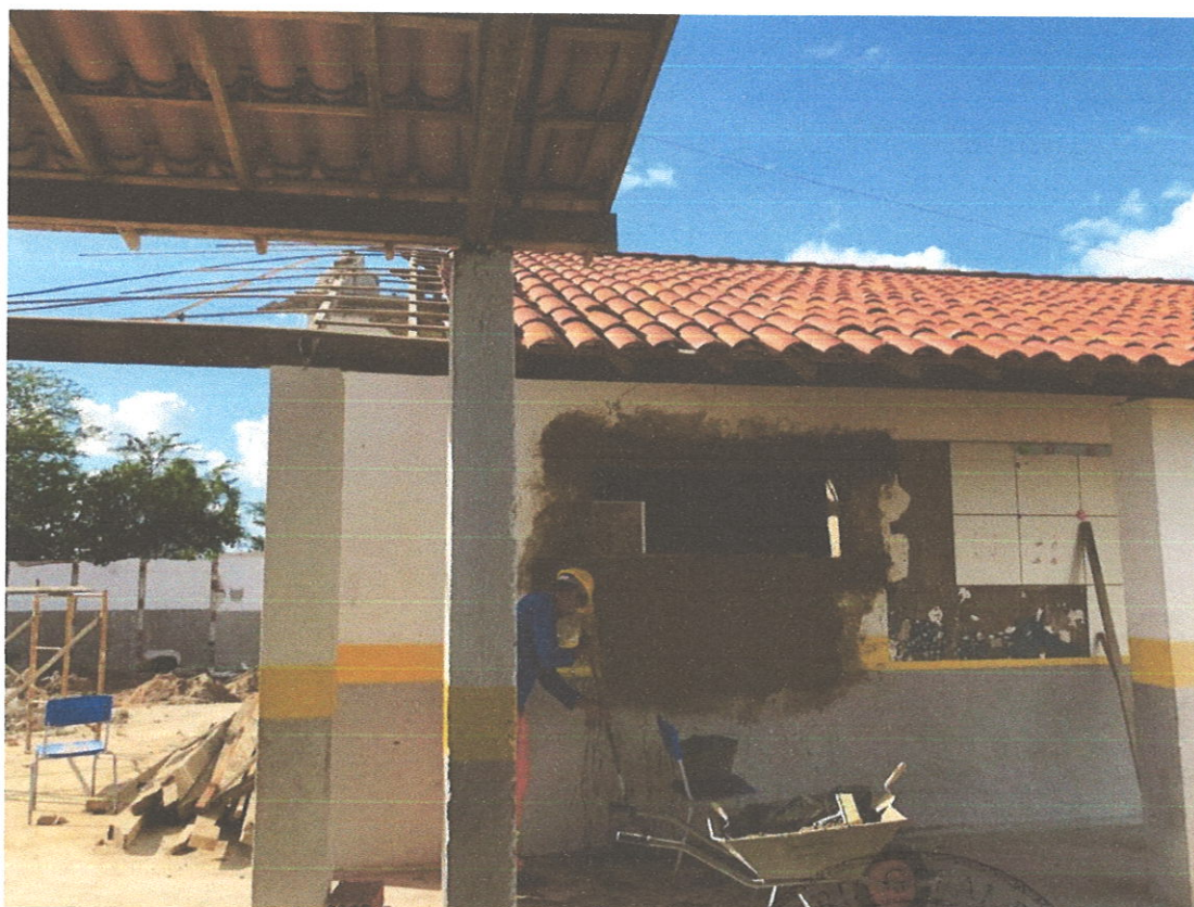
FOTO 25 EXECUÇÃO DE REBOCO
