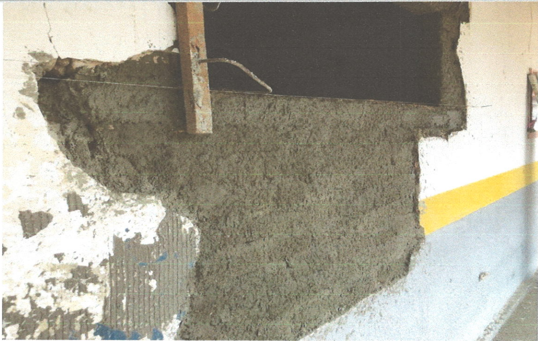
FOTO 20 REQUADRO DAS JANELAS COM ALVENARIA
