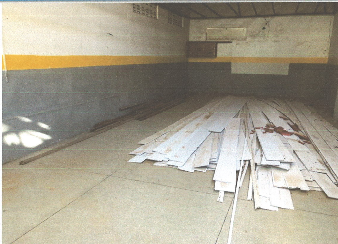
FOTO 12 REMOÇÃO DE FORRO PVC
