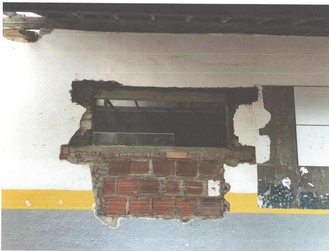
FOTO 26 EXECUÇÃO DE VERGA E CONTRA-VERGA NAS JANELAS
