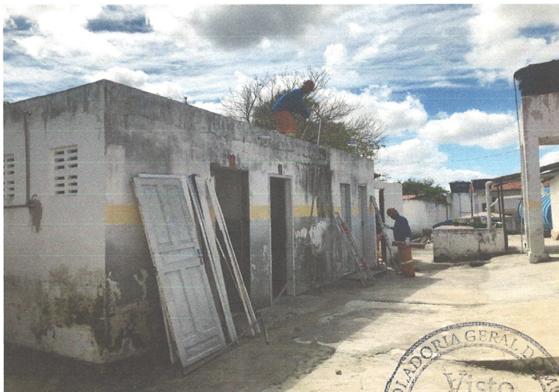
FOTO 01 DEMOLIÇÃO DE TELHAMENTO
