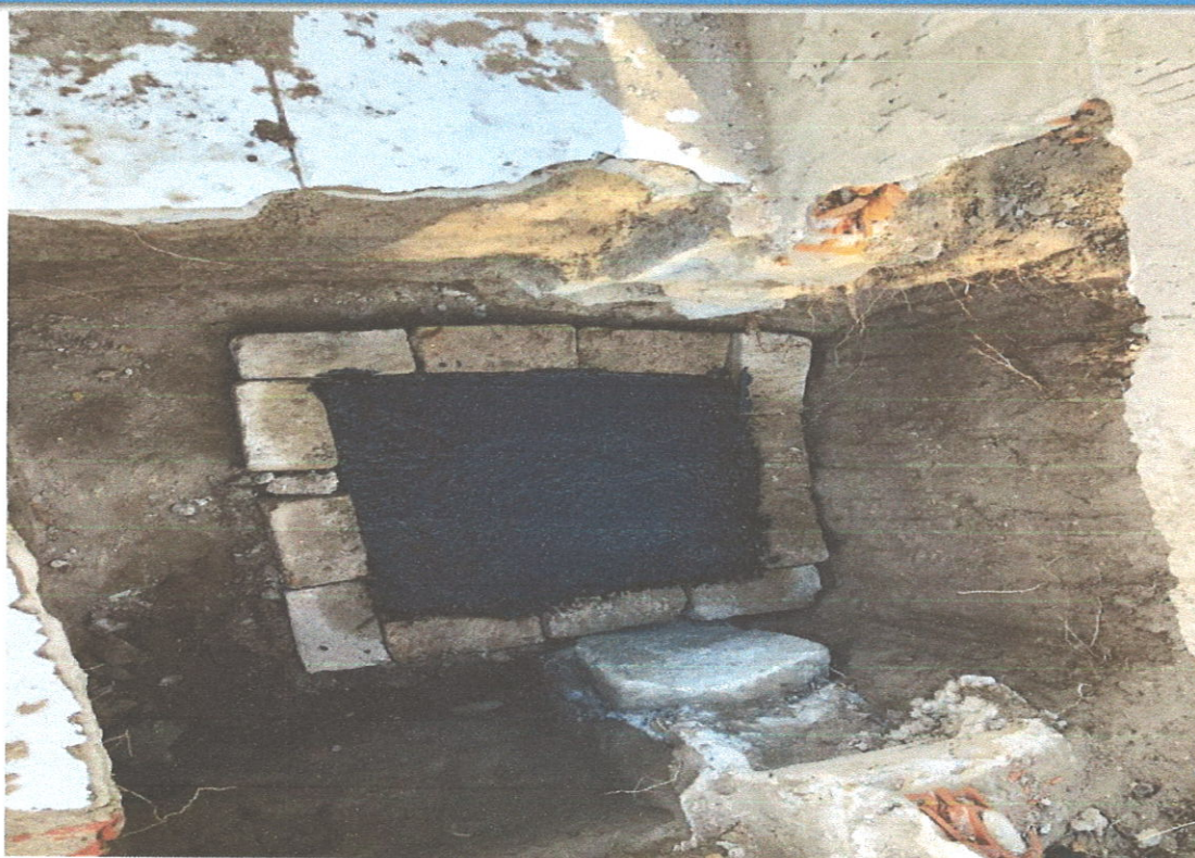
FOTO 24 IMPERMEABILIZAÇÃO DO CONCRETO MAGRO
