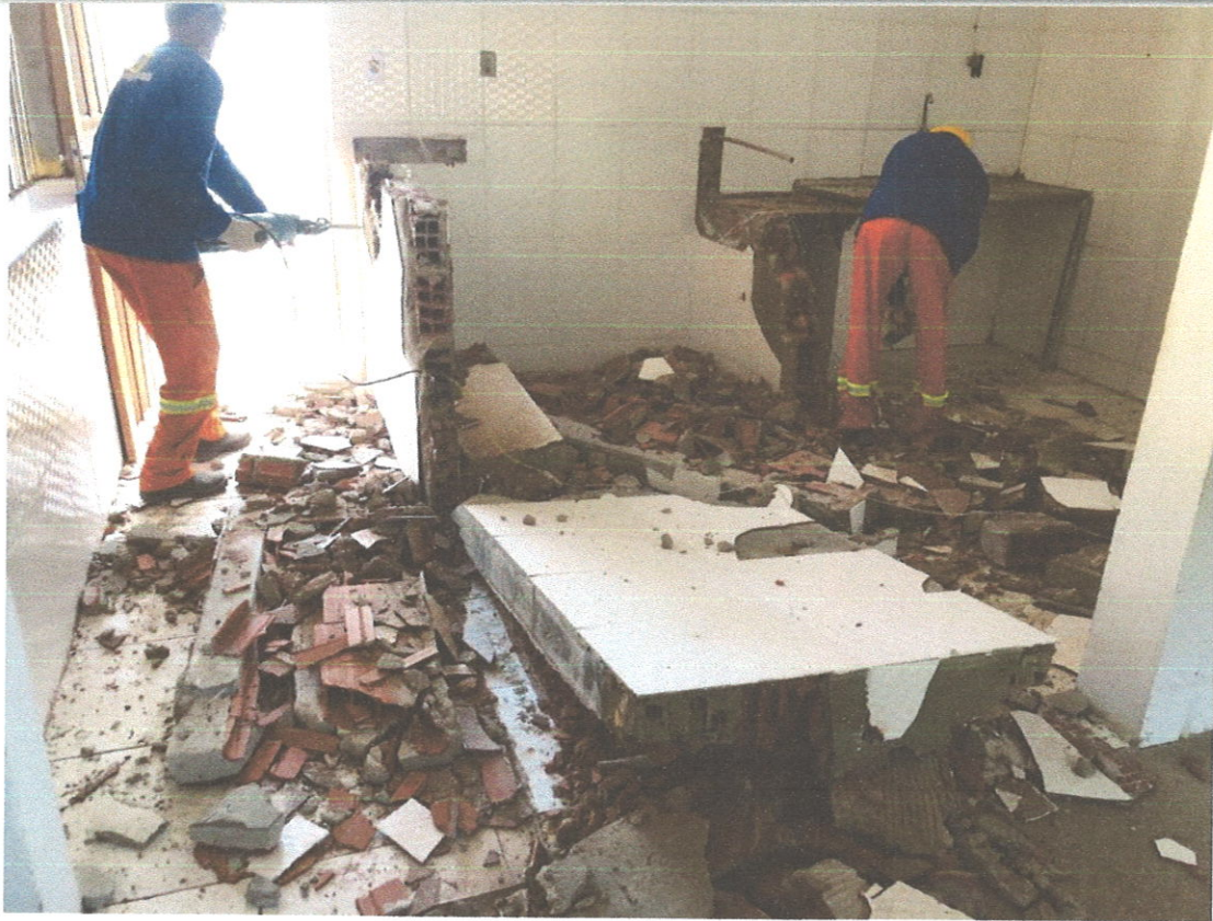
FOTO 17 DEMOLIÇÃO DE ALVENARIA
