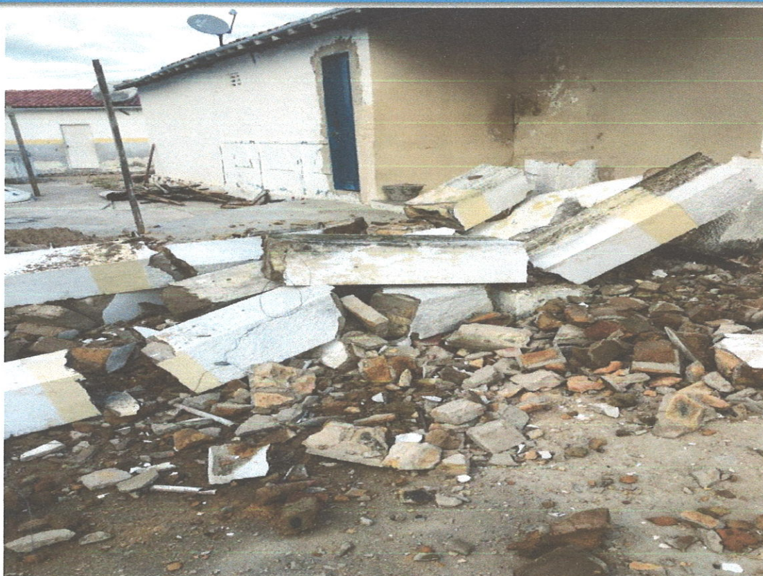
FOTO 15 DEMOLIÇÃO DE ALVENARIA
