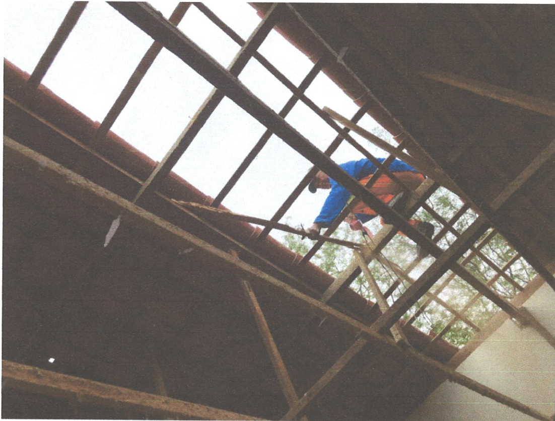
FOTO 09 REVISÃO DE TELHAMENTO
