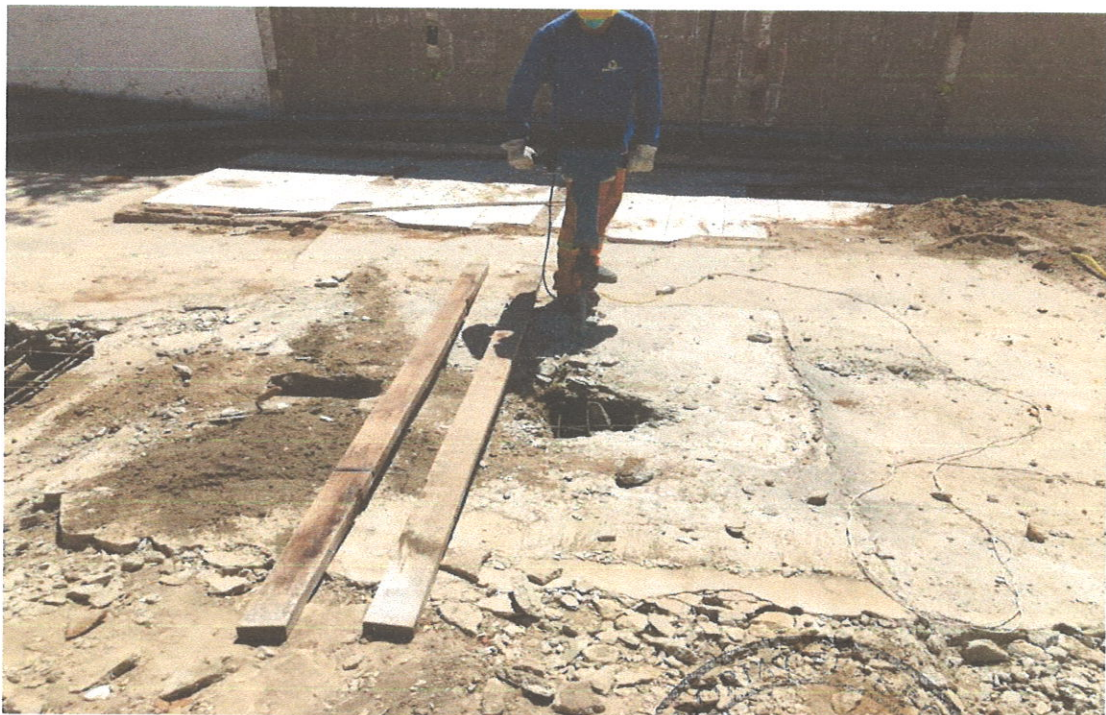
FOTO 18 DEMOLIÇÃO DE CONCRETO ARMADO
