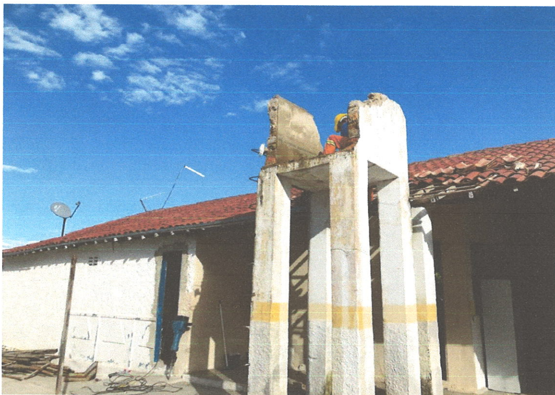
FOTO 14 DEMOLIÇÃO DE ALVENARIA E CONCRETO ARMADO
