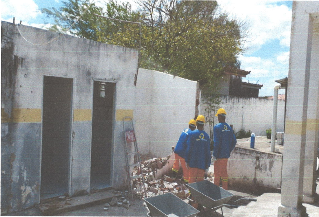
FOTO 03 DEMOLIÇÃO DE ALVENARIA
